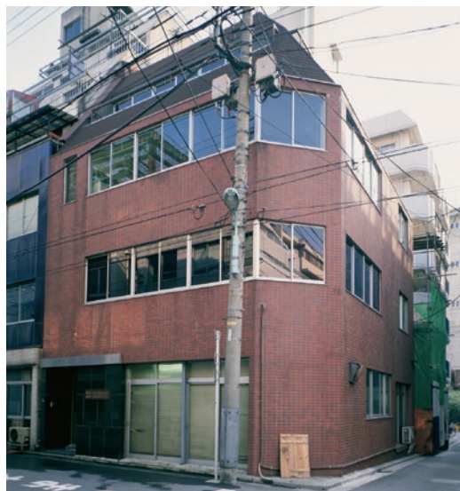
鉄筋コンクリート造4階建て、 延べ床面積 336.54㎡の新本社ビル
