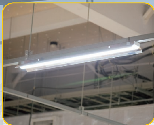
3階印刷部内のLED照明は色をできるだけ自然光に忠実に再現することを特徴とした高演色タイプ
