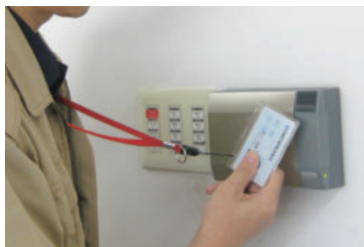
ICカードによる入出制限。 権限設定により入れるエリアが決められています。
